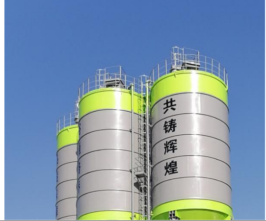
筒仓仓顶除尘器
